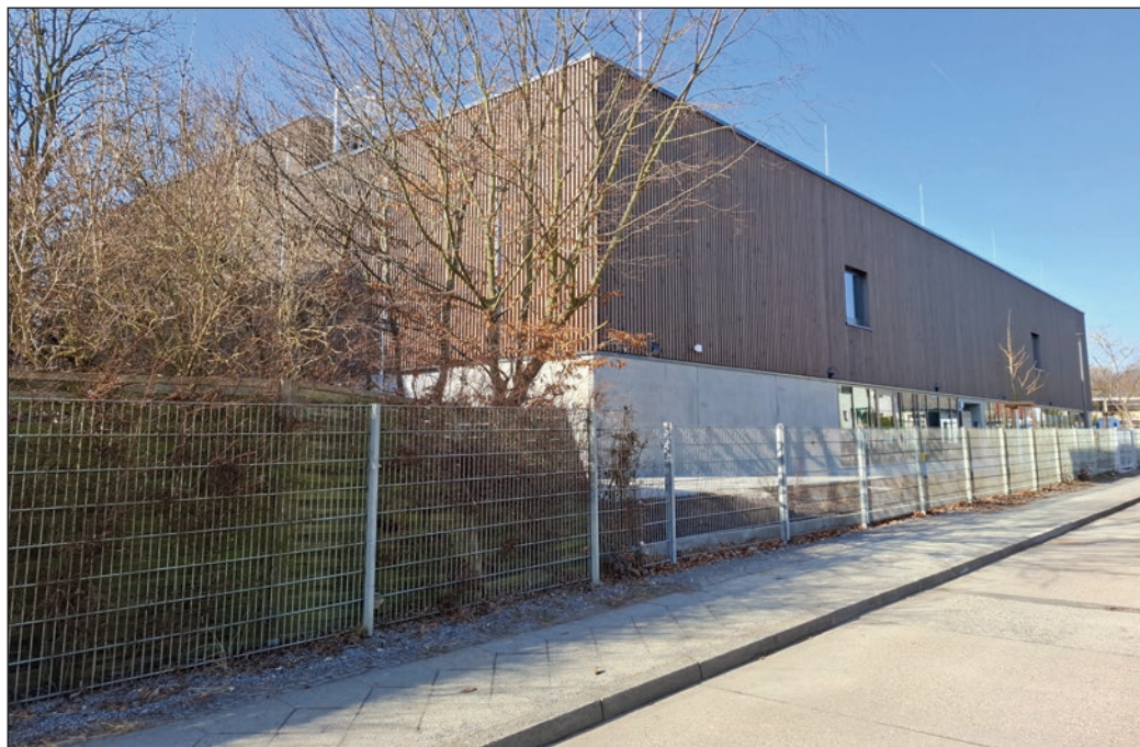
Neue Sporthalle an der Lutherstraße von außen. .
