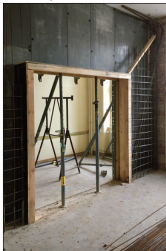
So wie auf diesem Bild sah es während der langen Sanierungsphase fast überall in der Schule aus.
